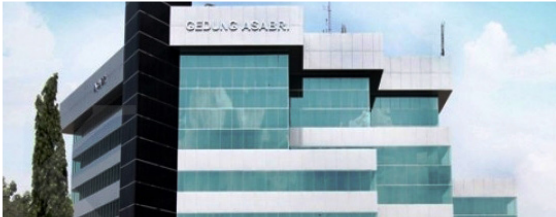
Gambar 10 Gedung Kantor Pusat PT ASABRI
