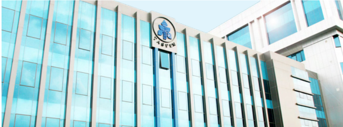
Gambar 9 Gedung Kantor Pusat PT Taspen
