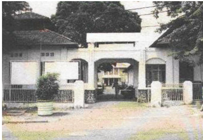
Gambar 3 Gedung Kantor Urusan Pegawai (KUP) era 1950an di Jl. Kramat Jakarta
